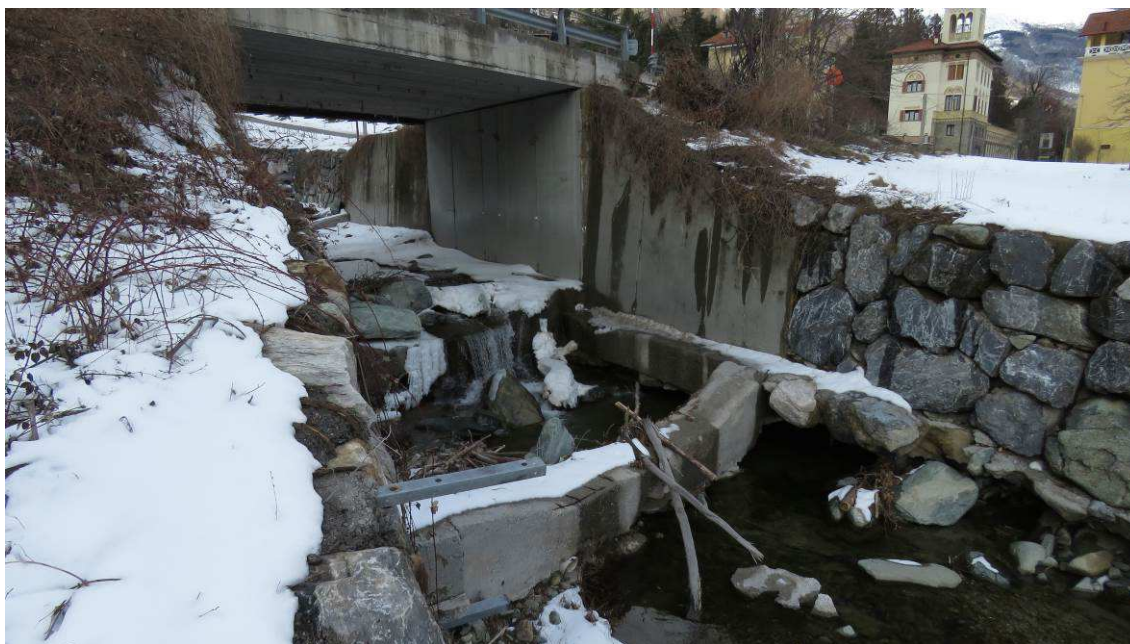
Foto n° 9: intervento località Chiappino, appena a valle della Strada Statale n° 28; l'alveo, completamente limitato da opere di difesa spondale di diversa tipologia. L'alveo è impostato in depositi alluvionali a granulometria grossolana prevalente.
