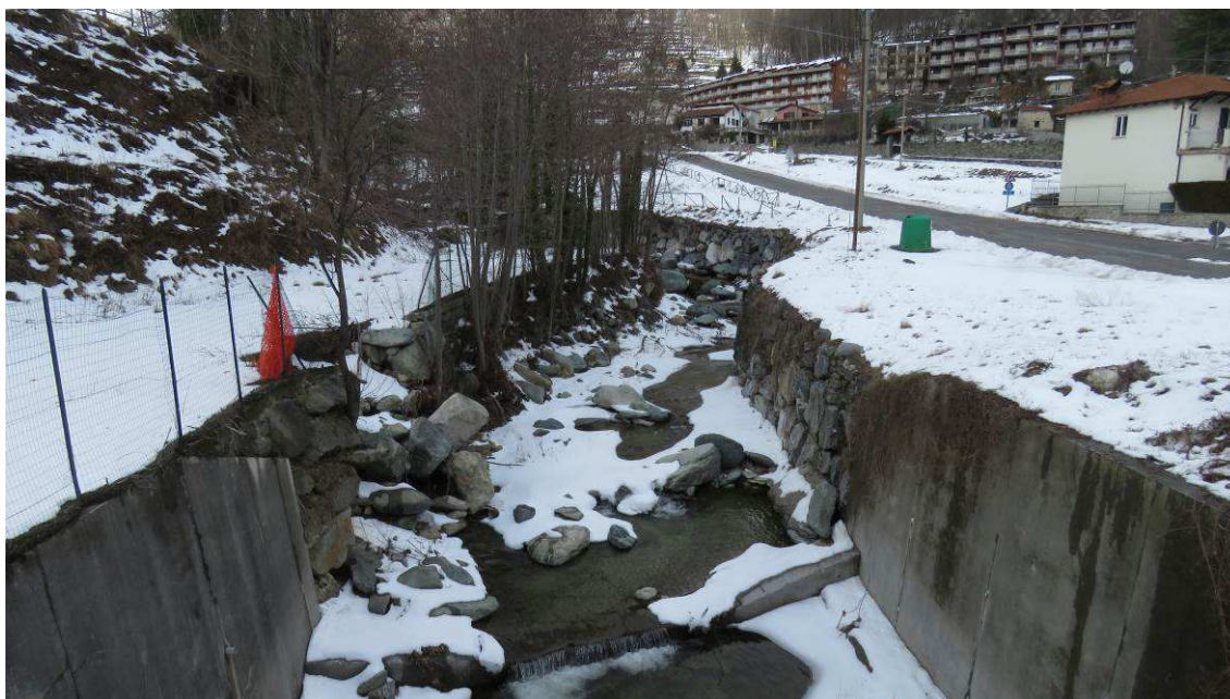
Foto n° 8: intervento località Chiappino, a monte della Strada Statale n° 28; l'alveo, completamente limitato da opere di difesa spondale di diversa tipologia. L'alveo è impostato in depositi alluvionali a granulometria grossolana prevalente.
