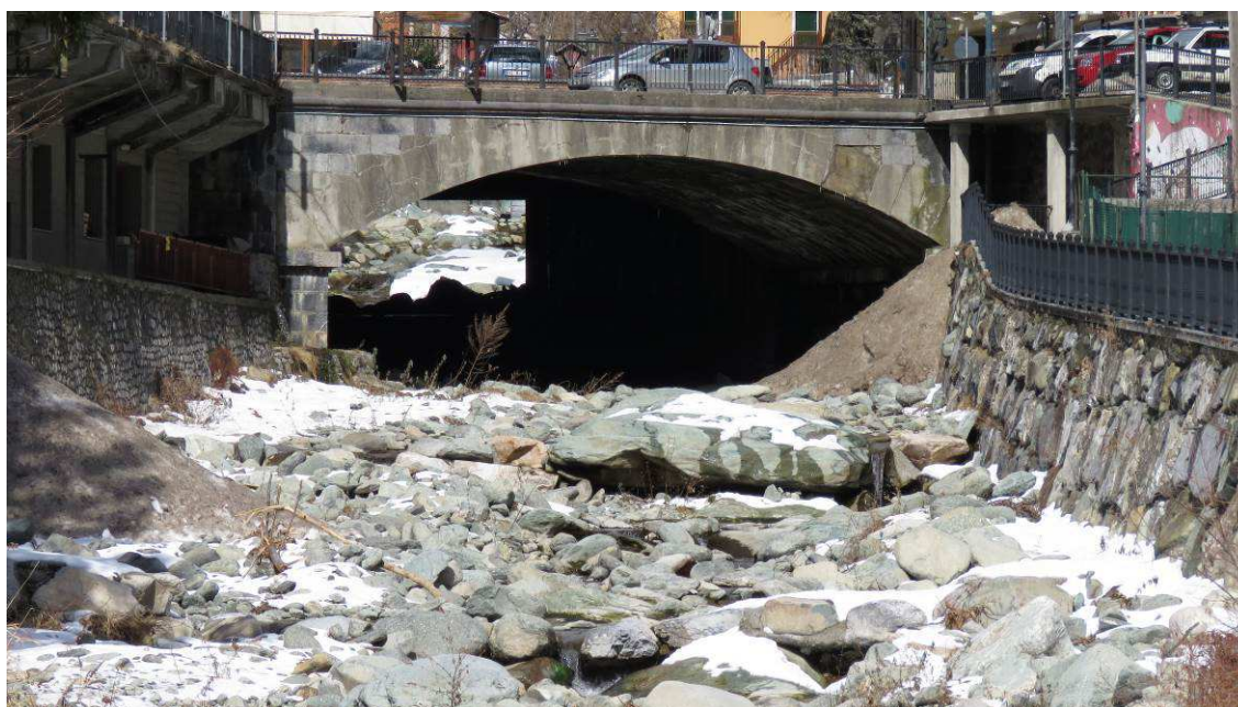
Foto n° 6: intervento località capoluogo – Piazza della Libertà; l'alveo, completamente limitato da opere di difesa spondale di diversa tipologia e periodo costruttivo. L'alveo è impostato in depositi alluvionali a granulometria grossolana prevalente.
