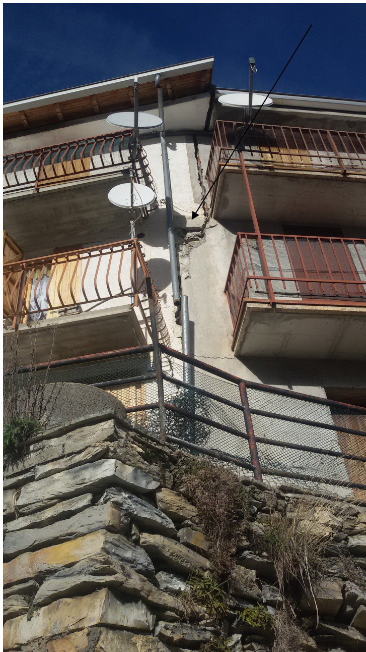
FOTO 2: Punto di congiunzione tra il fabbricato 1 e 2
