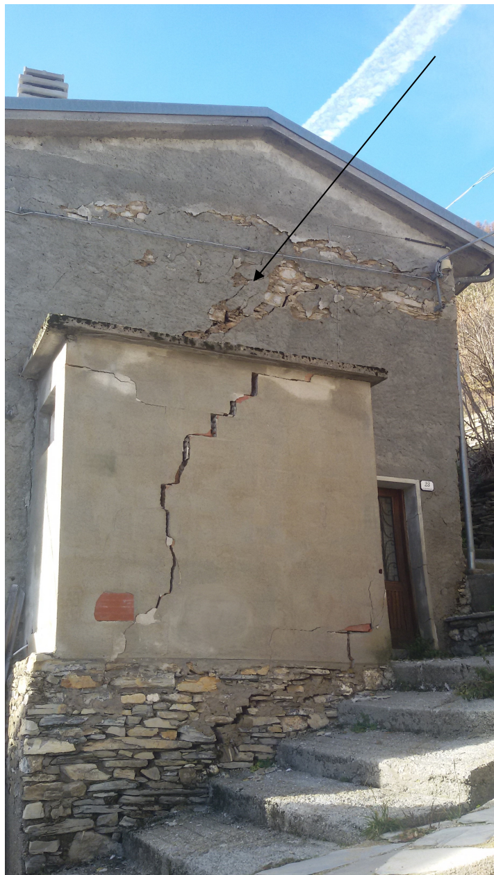
FOTO 3: Punto di congiunzione tra il fabbricato 1 e 2
