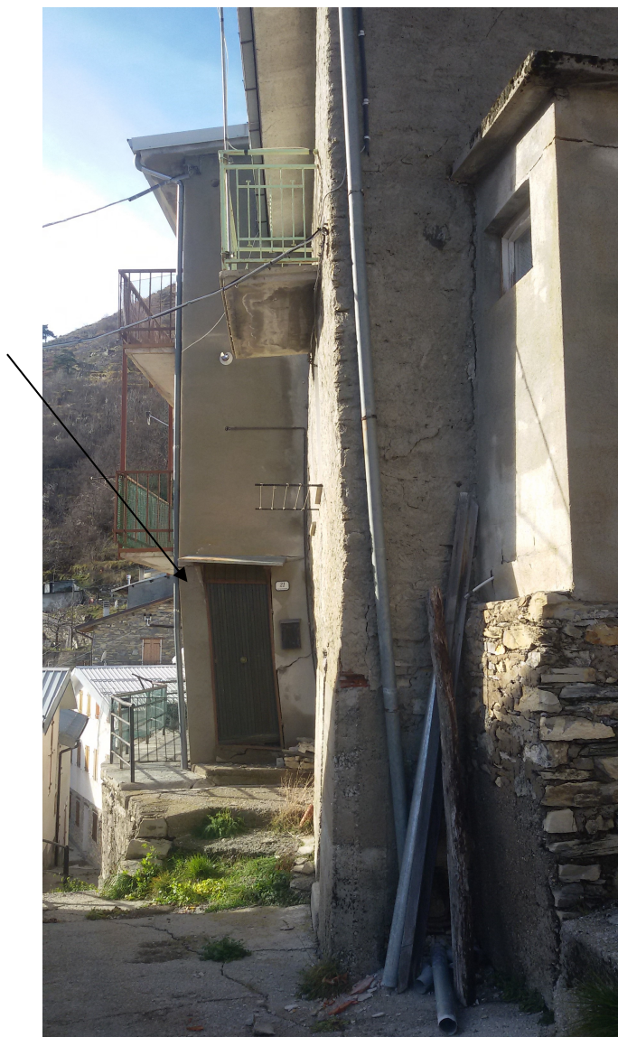
FOTO 1: L'ingresso ad un alloggio del fabbricato 2
