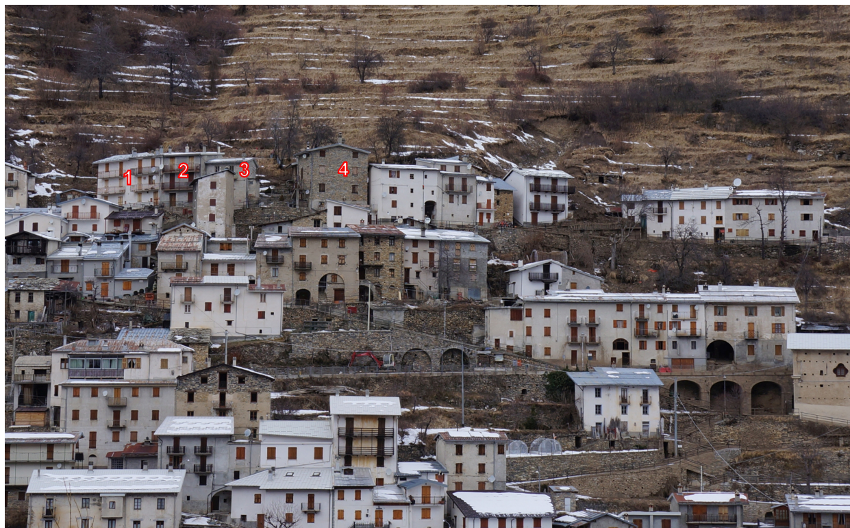
Fotografia stato attuale: i fabbricati 1, 2 e 3 verranno demoliti a causa delle pesanti lesioni strutturali
